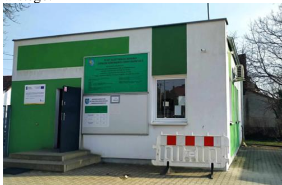
Planowane miejsce lokalizacji czujnika jakości powietrza
