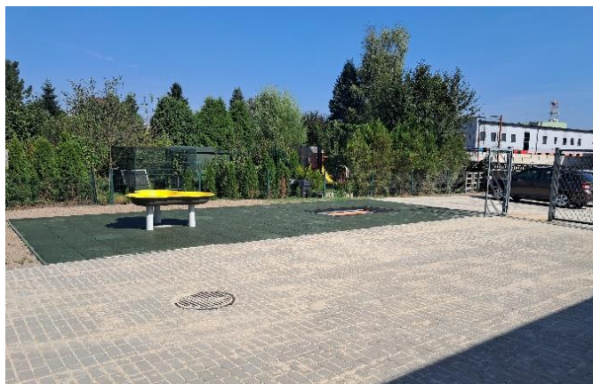
Nowe dojście i dojazd do przedszkola wykonane w ramach dostosowania do potrzeb dzieci z niepełnosprawnościami w Przedszkolu Publicznym Nr 2 z Oddziałami Integracyjnymi w Krapkowicach
