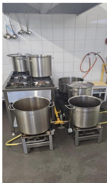
Pomieszczenie kuchni – wyremontowane w ZSP Nr 4 w Krapkowicach
