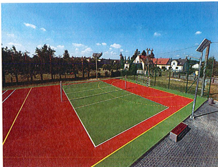
Fot. Nowo wybudowane boisko sportowe przy Publicznej Szkole Podstawowej w Żywocicach
